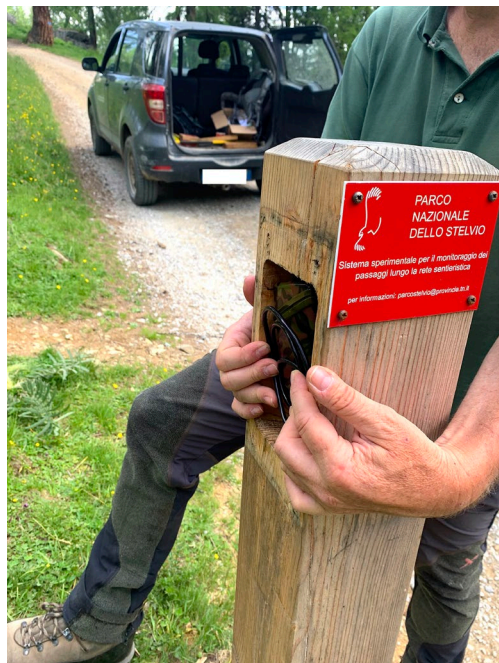
Figura 3 – Installazione del dispositivo contapersone.
