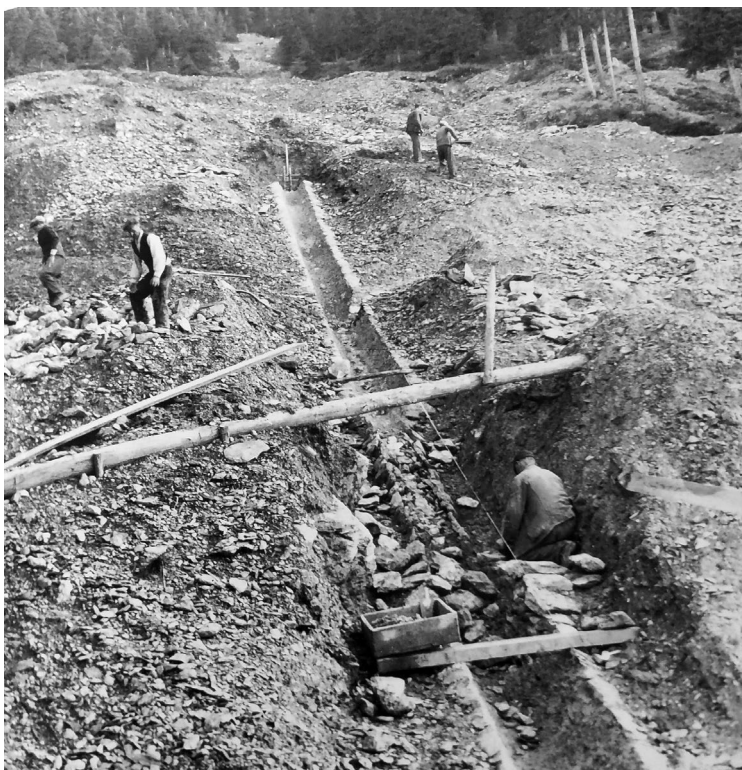
A sinistra: Rio Maggiore. Realizzazione di una cunetta in sassi per la raccolta dell'acqua nella parte alta del bacino idrografico, a monte di Vetriolo.
