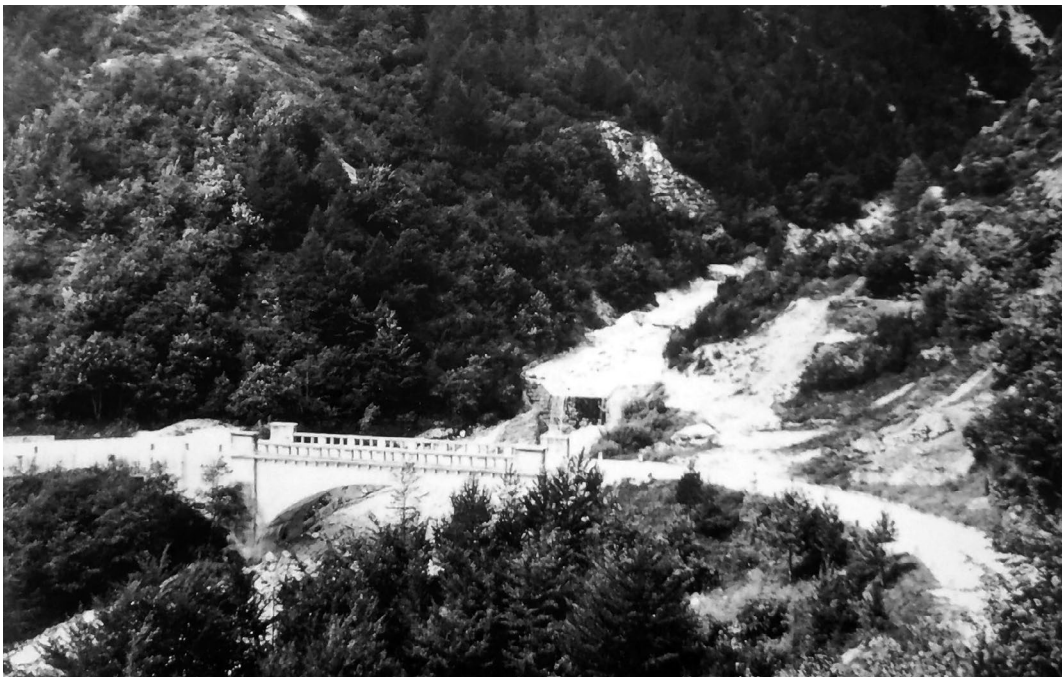
Torrente Centa. Anno 1958. Stessa zona della foto precedente con evidente effetto della sistemazione eseguita.
