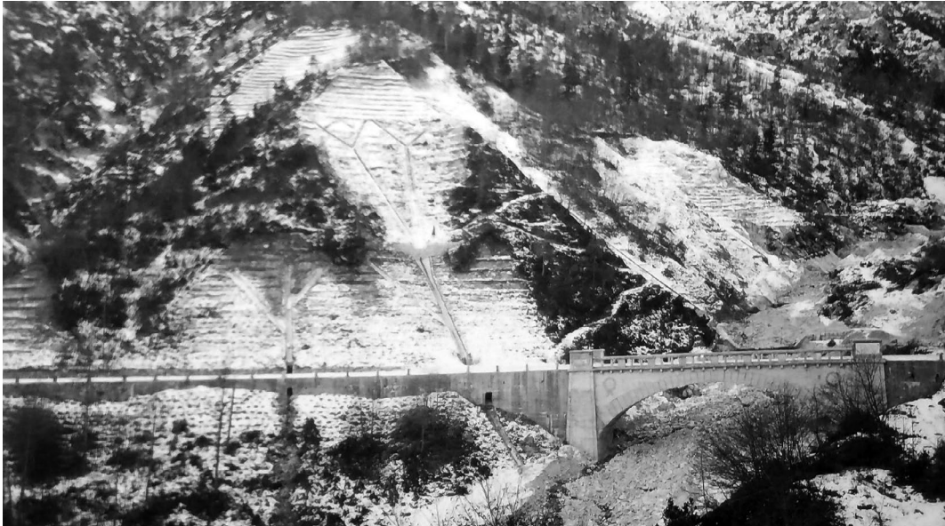
Torrente Centa. Anno 1934. Area franosa a monte del ponte con sistemazione appena ultimata.
