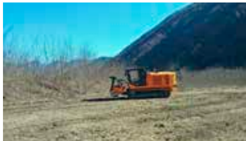
Foto 3 – Piazzale strategico le "Giare" in comune di Roncegno Terme in fase di realizzazione.
